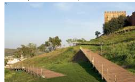
Franchir le talus
