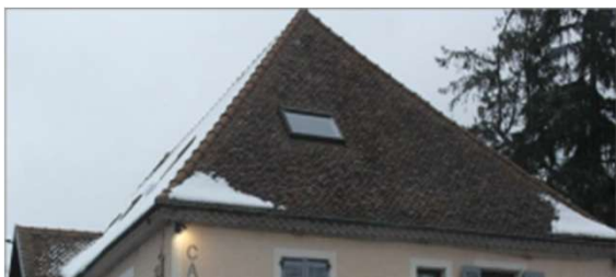
Toitures en tuiles écaille et Génoise
