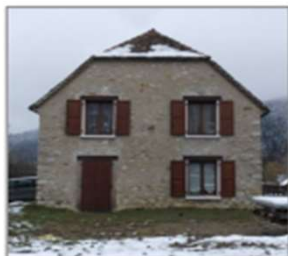
Toitures en tuiles écaille et Génoise
