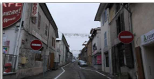
Massivité du bâti & alignement à la rue
